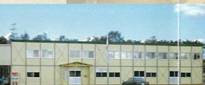
切妻型のルーフ部分をフラットへ。断熱、積雪対策などが大きく前進し、北国にマッチする建物に進化した。
