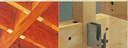
新工法の模索。3階建て物件に木造住宅を、エンジニアウッドと新開発された金物を採用し、建て方まで取組むJ工法の導入。
