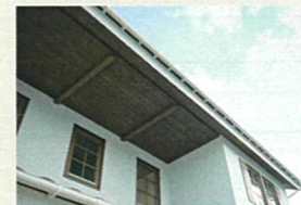
軒天にも木材を使用 天然寒水石の塗り壁とも相性ばっちり
