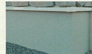
基礎の仕上げはシリコン素材で セメントの変色や汚れを防ぐ
