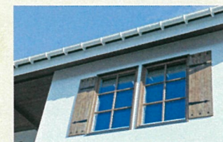
木サッシ + トリプルガラスの窓は 優れた断熱性・遮熱性で一年中快適
