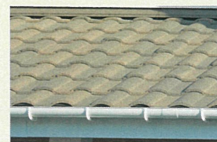
瓦風の屋根は表面の自然石粒が 雪止め効果を発揮。冬でも安心
