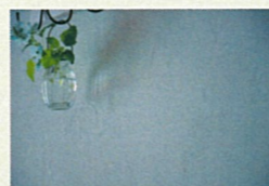
ゼオライトの内装 塗り壁は、消臭・ 調湿機能の優れたもの
